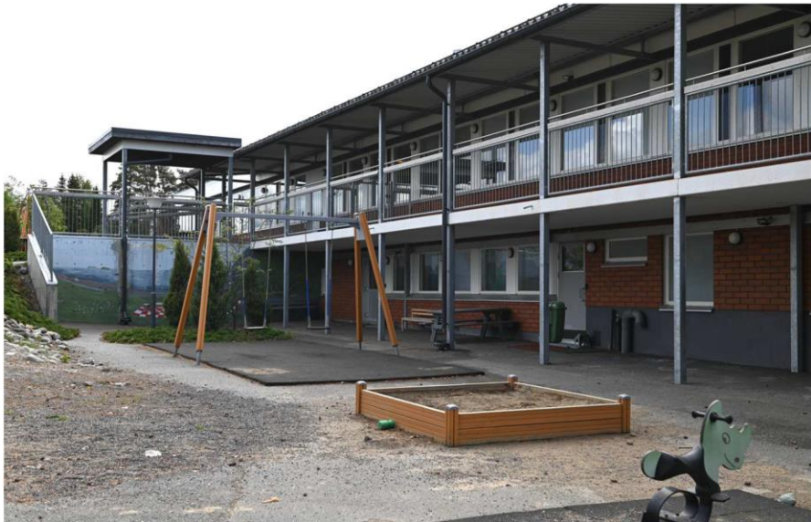
Kuva: Pohjoissivulle on rakennettu jälkeen päin nykyinen katettu luhti.
