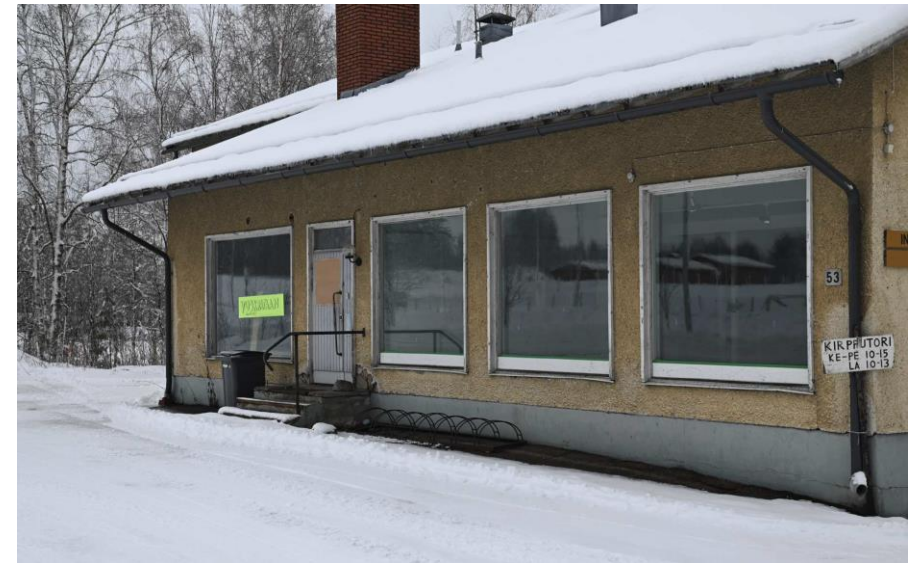
Kuva: Julkisivu tielle eli itään. Lasiukollinen paneeloitu puuovi pitkällä vetimellä ja jaottomat smyggilautojen rajaamat näyteikkunat alkuperäisessä koossaan.
